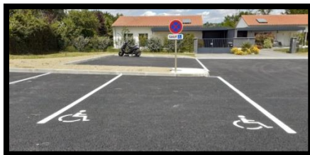
EMPLACEMENT HANDICAPE SUR LE PARKING DE L'ETABLISSEMENT AVEC SIGNALISATION VERTICALE ET HORIZONTALE
