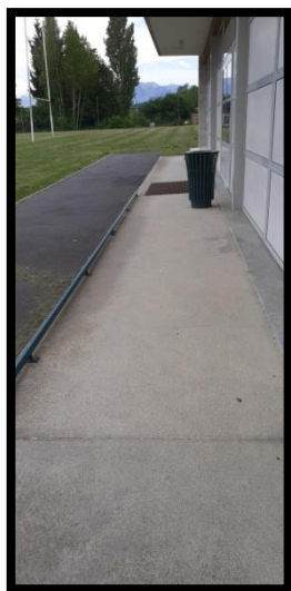
RAMPE CIMENTEE AVEC GARDE FOU
